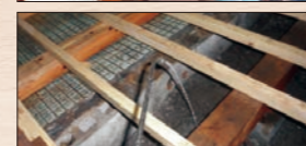
床をはがしての駆除工事
